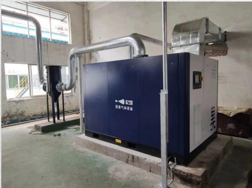
江苏韩泰轮胎 (1台 EVS 3000, 45KW) 以前运行1台75KW水环泵
