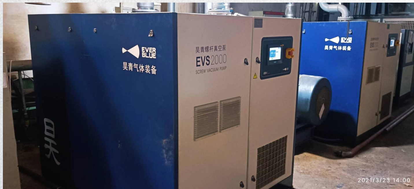
浙江兆奕光电有限公司 (4台 EVS 2000, 37KW) 拍摄到第一期2台
