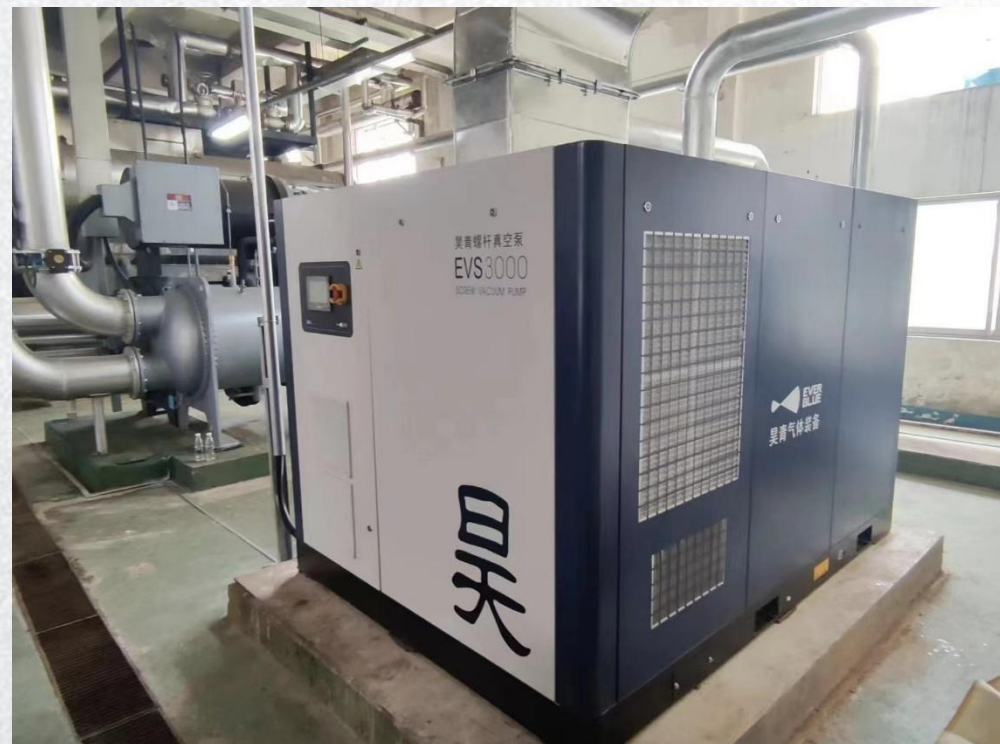
江苏韩泰轮胎 (1台 EVS 3000, 45KW) 以前运行1台75KW水环泵
