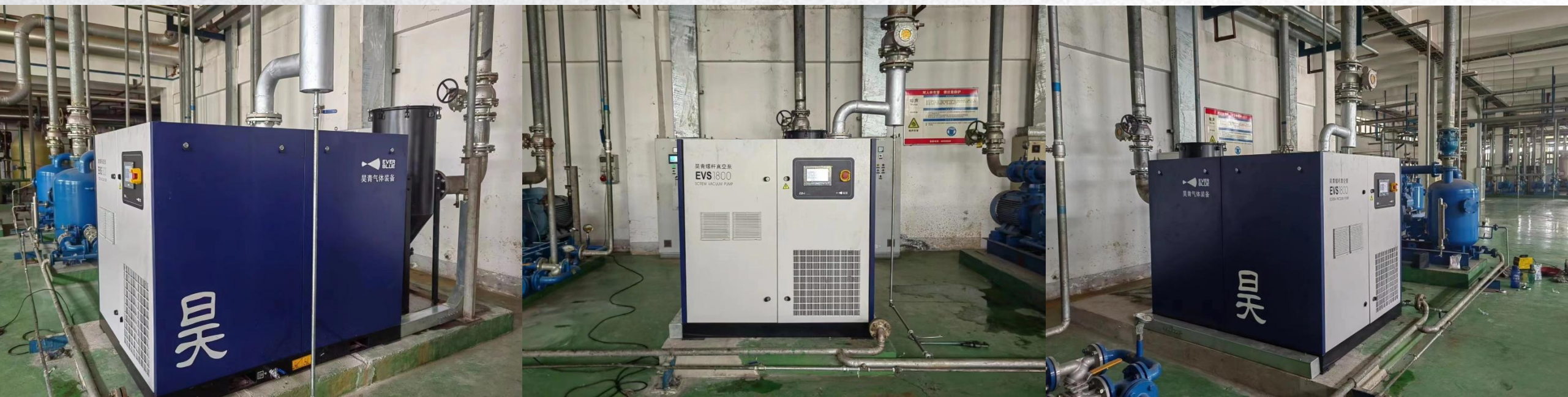
重庆韩泰轮胎 (1台 EVS 1800, 30KW) 以前运行1台45KW水环泵
